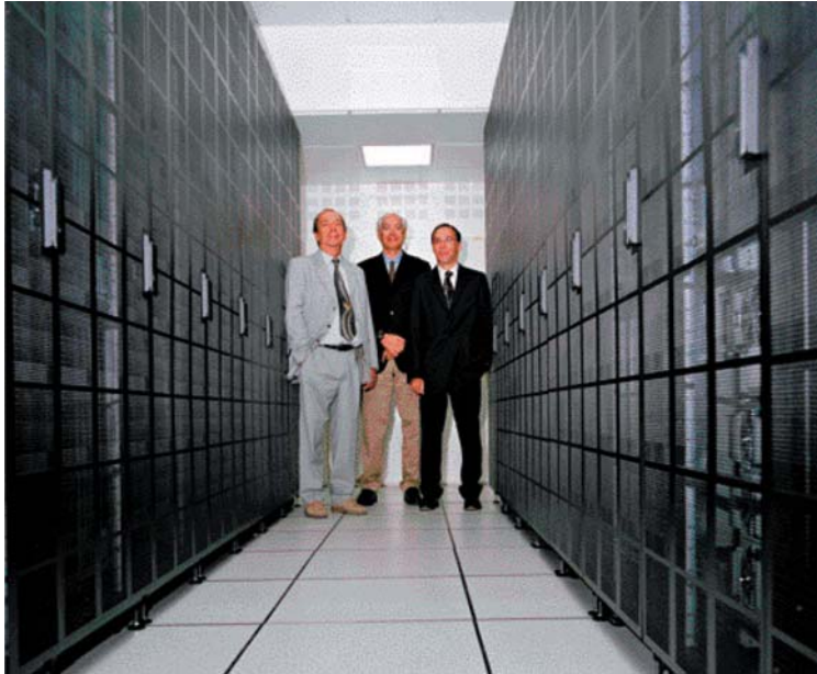
LES AUTEURS devant une rangée d'armoires de la machine Tera.
